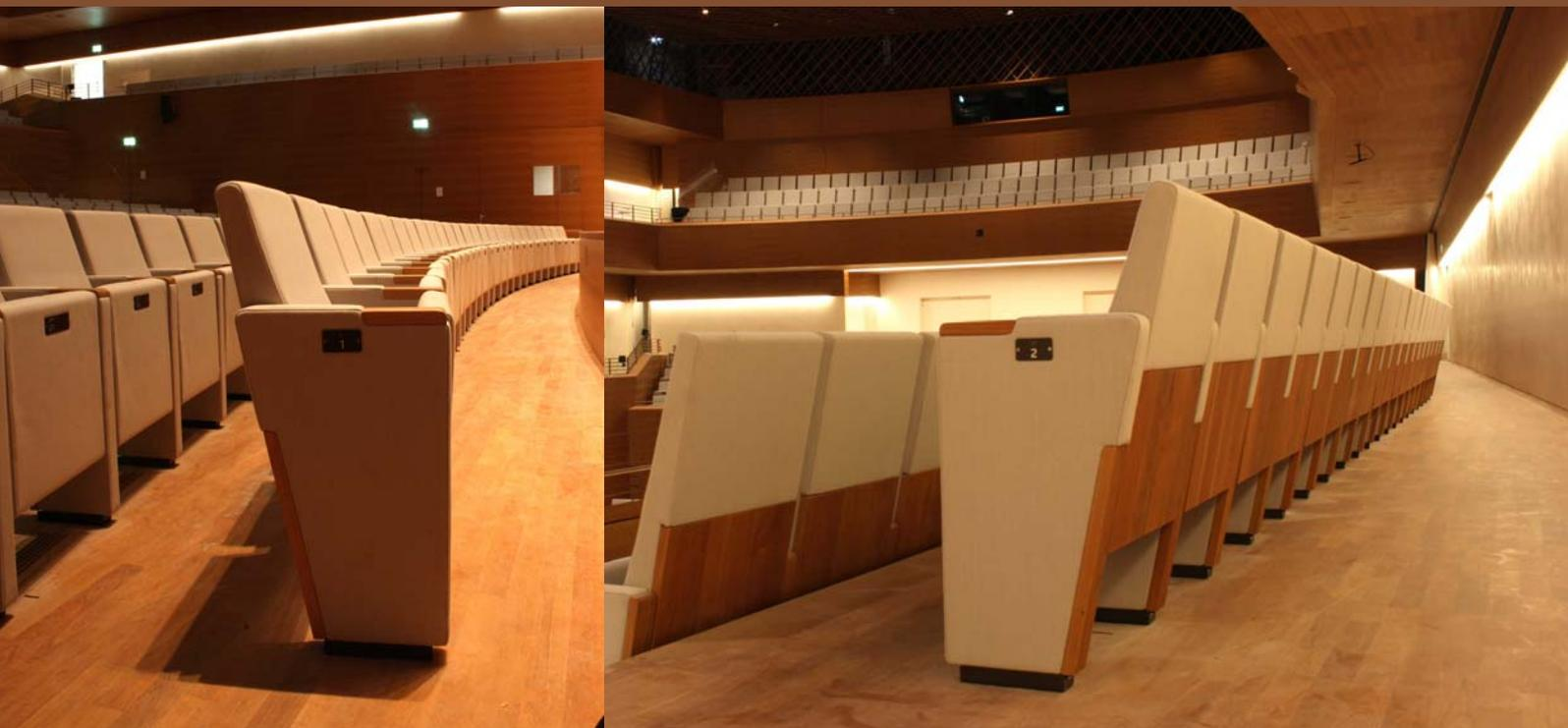
La butaca fue acústicamente diseñada en colaboración con los consultores Müller-BBM y Kahle Acoustics con una equilibrada combinación de tejido y madera. La salida de la climatización, la numeración en braille y la instalación en curva en 5 distintos niveles del auditorio fueron la clave del diseño y fabricación de las mismas.
